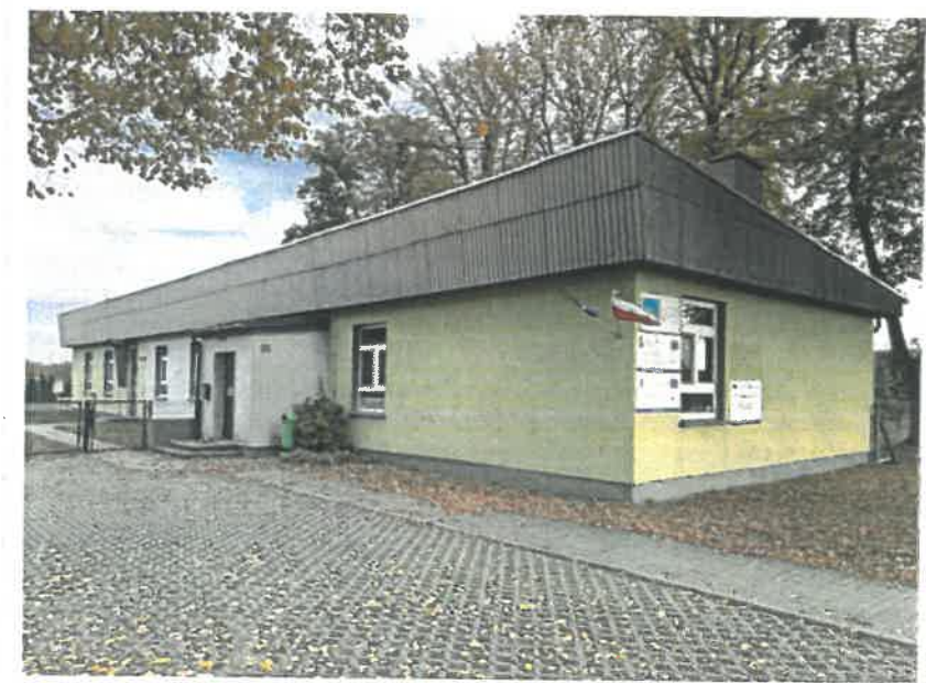
Budynek przedszkola oraz siedziby Lokalnej Grupy Działania „Krajna nad Notecią”
