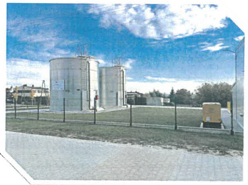
Stacja uzdatniania wody
