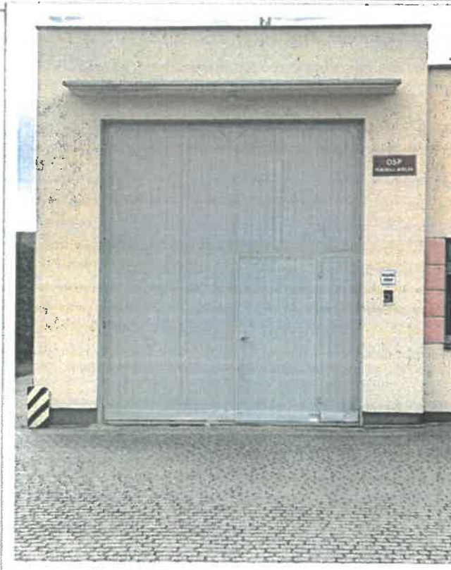
Budynek remizy i świetlicy wiejskiej
