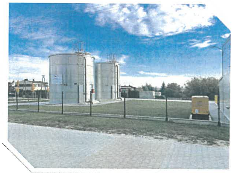
Stacja uzdatniania wody
